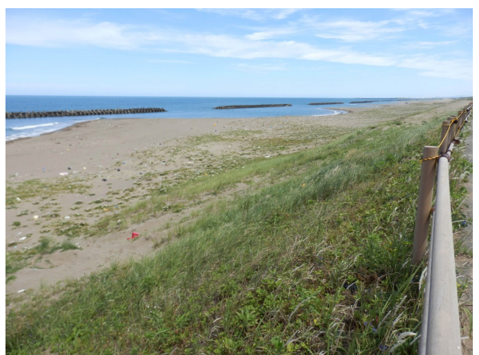
図11 離岸堤近くの砂浜(金沢市下安原町)
