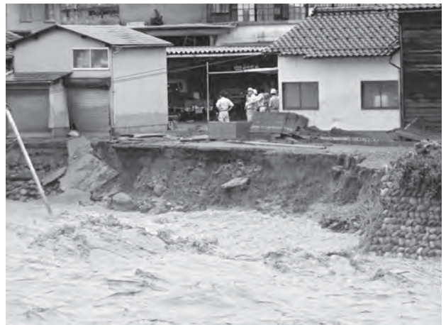
図38 館町 (10:25撮影) 図37の隣接地。川沿いの道路がわずかだけ残っている。
