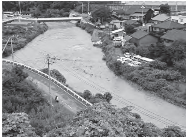
図36 銚子口橋下流遠望 (2008年7月8日撮影) 図35と同所。画面右端の石積み護岸の位置に注目。図35と比べると流失箇所がよく判る。この日も小規模な浸食が起こった。
