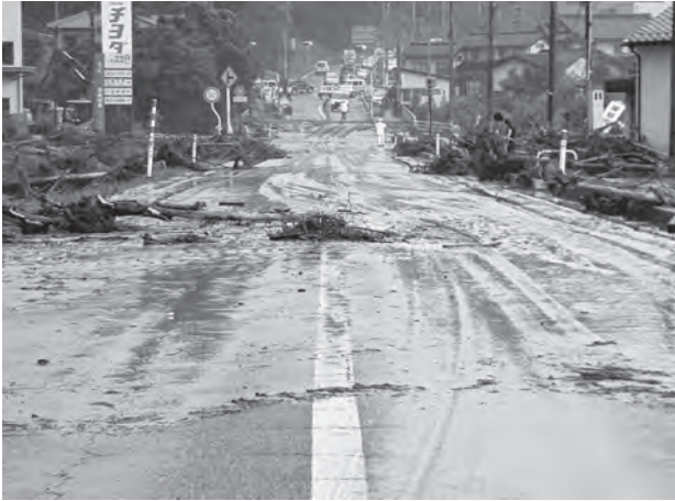
図27 県道10号線の冠水跡 (9:13撮影) 東浅川保育園裏から浅川橋方向を望む。
