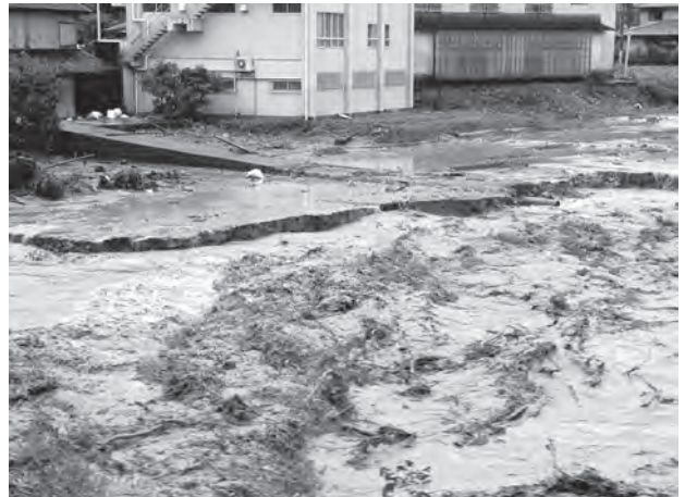
図30 支流戸室川との合流地点 (8:54撮影) 河川敷の一部が浸食されて無くなった。
