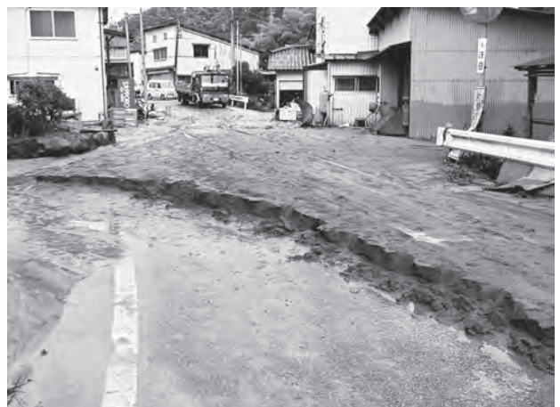
図32 銚子町内の旧道 (10:15撮影) 路上に砂が厚く堆積した。
