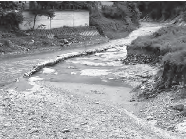
図11 袋板屋橋付近 (2008年9月1日撮影) 図10と同所。護岸に接する土手が削り取られ、基盤岩が現れた。
