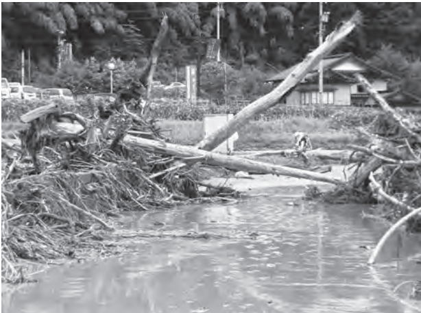
図29 田倉橋上 (10:02撮影) 橋上に折り重なった流木。
