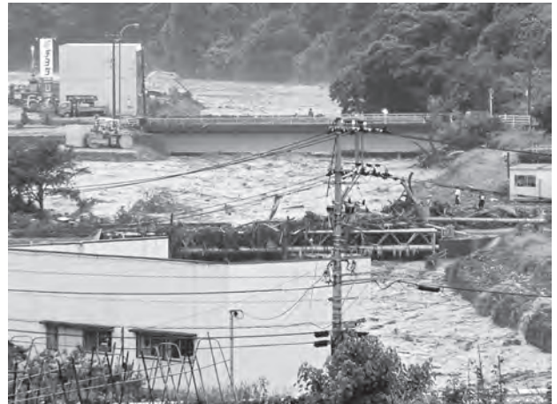
図24 浅川橋田倉橋遠望 (8:50撮影) 浅川橋 (奥)、田倉橋 (手前)。この時、水位は既にかなり下がっていた。
