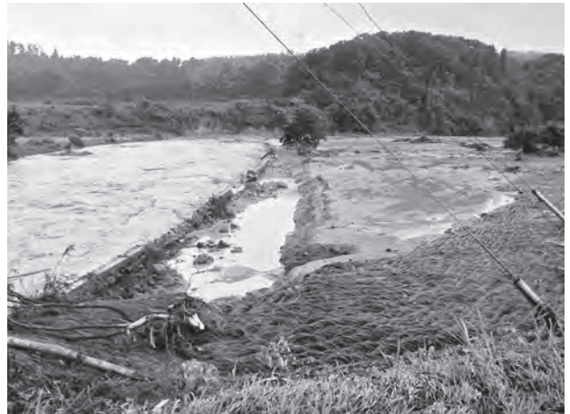
図12 袋板屋橋より下流を望む (9:18撮影) 護岸の上部を壊して、川から水田地帯に水が流れ込んだ。
